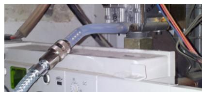
Gebrauchsfähigkeitsprüfung mit dem Adapter über die Gastherme
